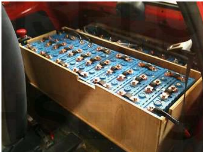
写真2. バッテリー作業中
